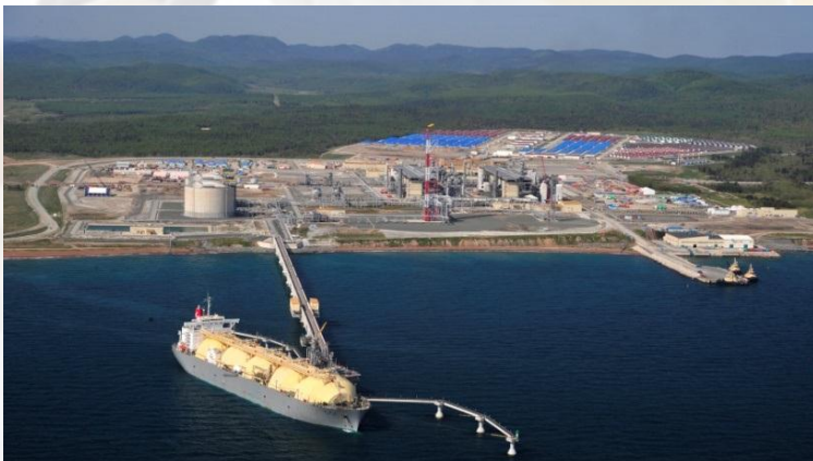
SAKHALIN II LNG PLANT
