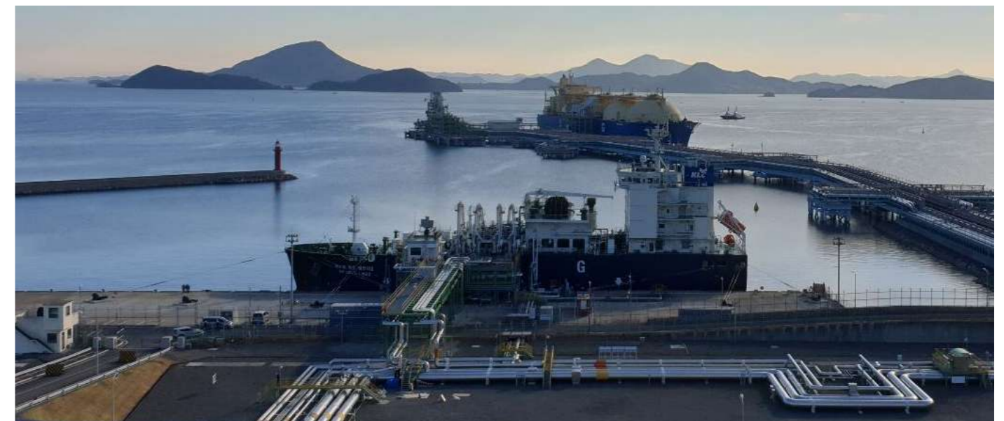
TY LNG Terminal - Courtesy of Kogas
