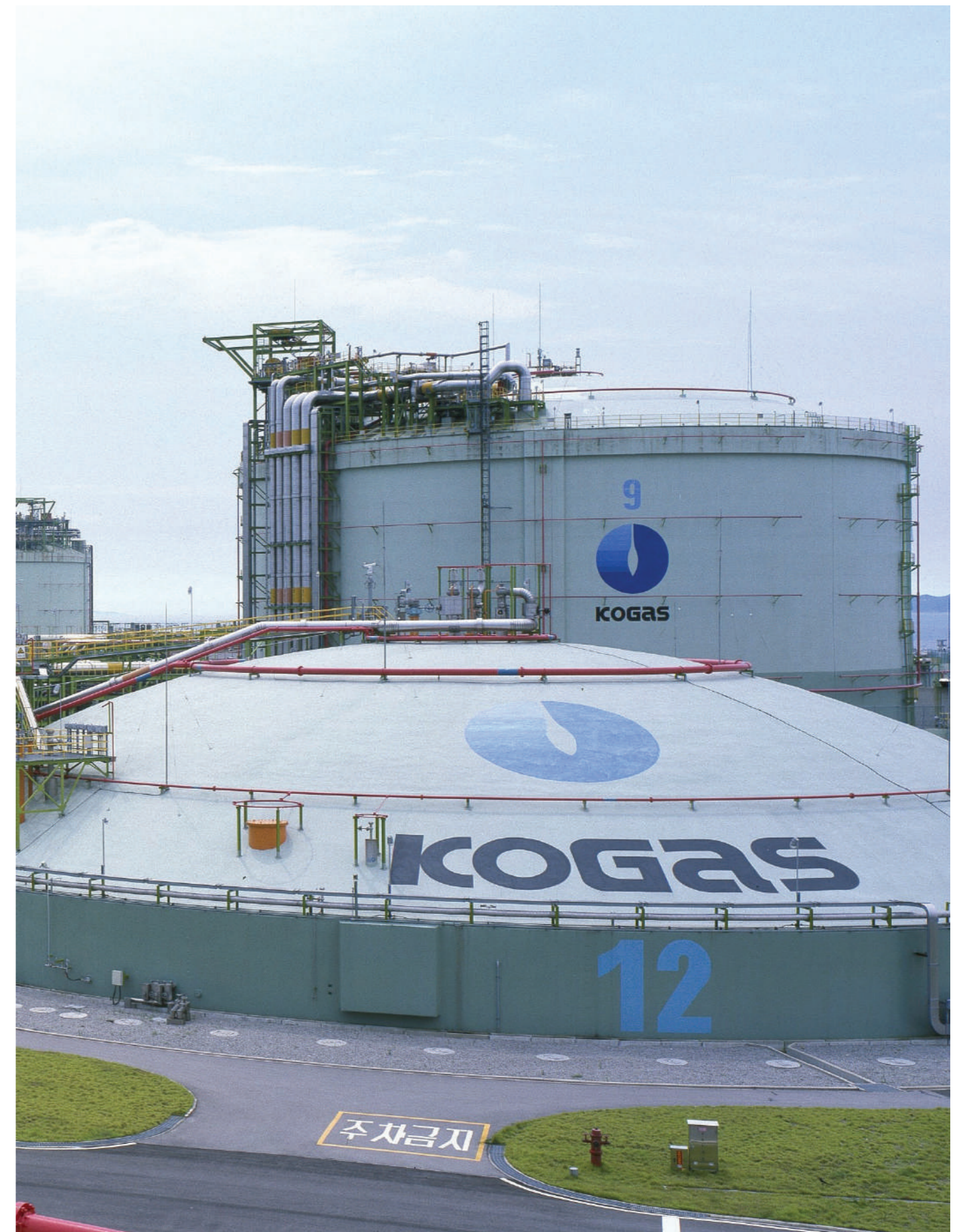
Incheon LNG Terminal - Courtesy of KOGAS
