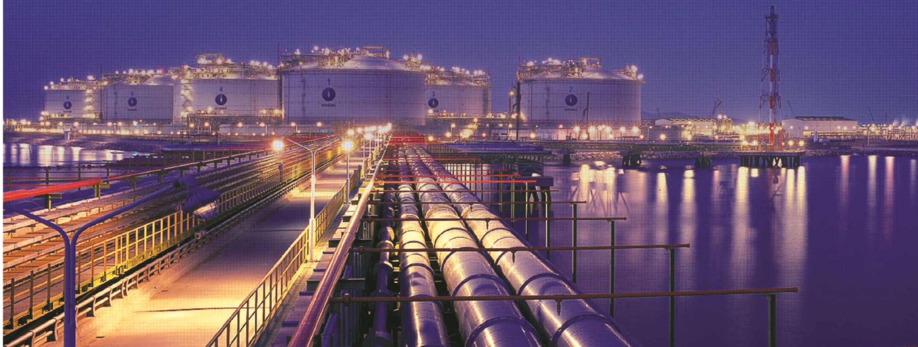
Incheon LNG Terminal - Courtesy of KOGAS
